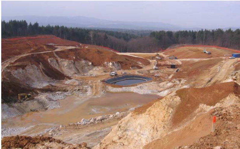
Priprava skleda novega dela odlagališča, marec 2006
